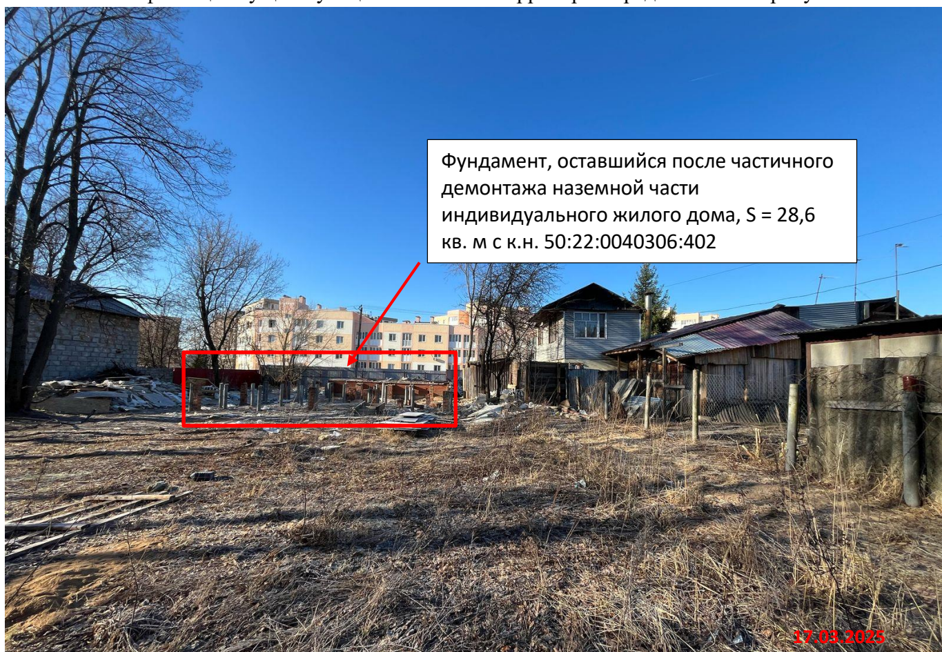
Вид 1. Фотофиксация земельного участка 50:22:0040306:96 с севера
